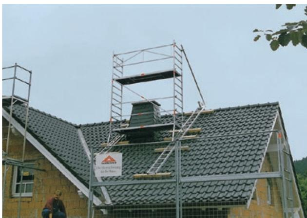
Das Alu-Dachkamingerüst darf an Dächern mit Neigung zwischen 30° und 60° verwendet werden und ist mit 2,0 kN/m<sup>2</sup> auf einer Belagebene einsetzbar. Es ist ein freistehendes Arbeitsgerüst aus leichten Aluminium Bauteilen. Arbeiten bis zu einer Höhe von 4 m können problemlos durchgeführt werden da die Belagebenen im Abstand von 25 cm eingehängt werden können.
