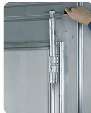
oder die vorhandene Durchbohrung Ø 6 mm nutzen, z.B. mit einem Stahlstift, Rundisen oder Inbusschlüssel
