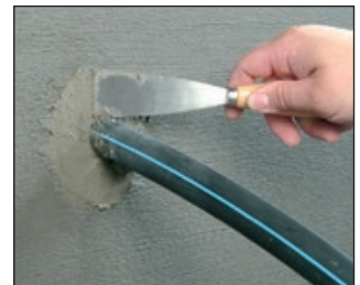
Verspachteln mit Schnellzement
