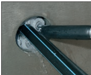
Füllen des Ringspalt
