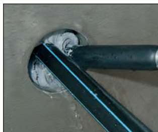
Füllen des Ringspaltes
