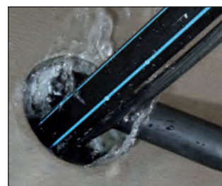
Einspritzen von Flex 2000
