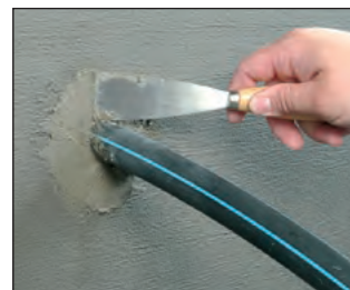
Verspachteln mit Schnellzement
