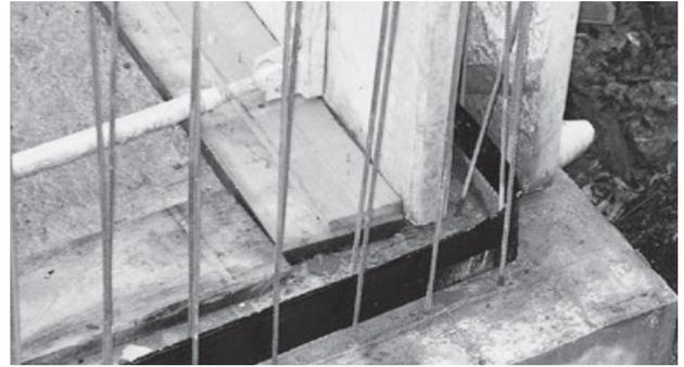
Dichtblech-M im Bereich zweischaliger Wände
