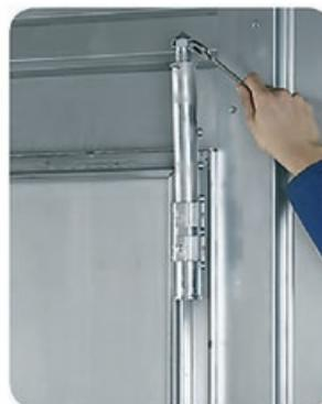
Den massiven Sechskantkopf mit Bohrspitze mit einem 27er Maulschlüssel fest unter dem Sturz arretieren,
