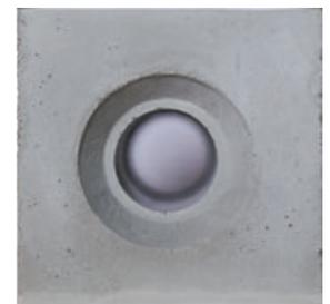
Spanstelle nach dem Entfernen des RivePipe
