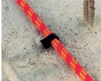
Befestigung mit Befestigungsclips die vorher in den Frischbeton gesetzt wurden, oder ins Bohrloch Ø 8 mm eingeschlagen werden. Abstand 15 cm
