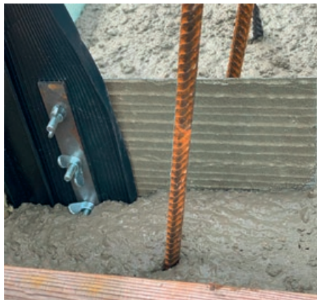
Übergang, Fugenbandanschluß - VIBA-Sinterflex
