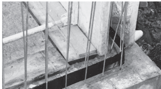
Dichtblech-M Premium im Bereich zweischaliger Wände
