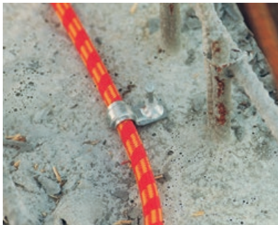
Befestigung mit Metallschellen zum Schießen oder Nageln. Abstand 15 cm
