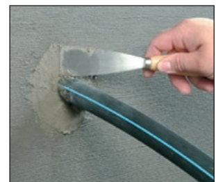
Verspachteln mit Schnellzement
