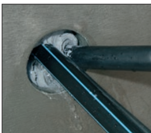
Füllen des Ringspalt
