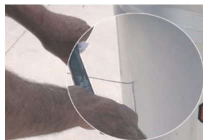
Schnelles Ausschalen mittels Reißleine
