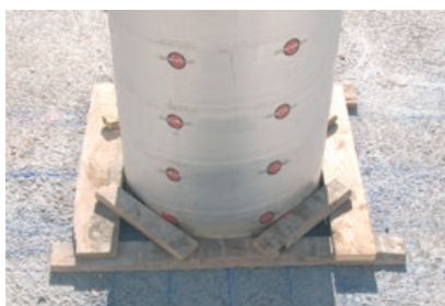
Schalrohr an der Unterseite durch Holz sichern (befestigen)
