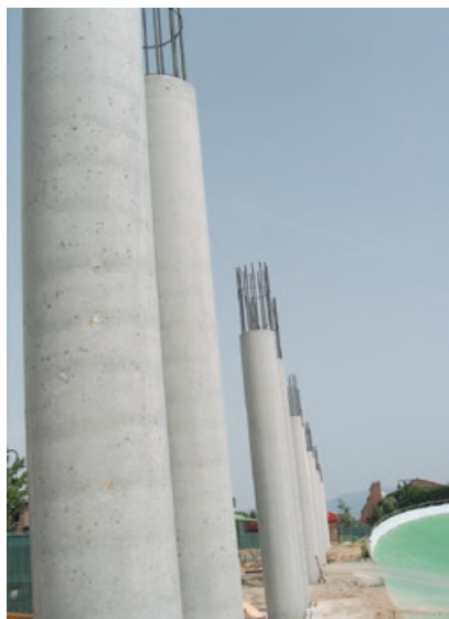
Ausführung STANDARD (Spiral) Betonoberfläche mit leichter Abzeichnung der spiralförmigen Wickelstruktur
