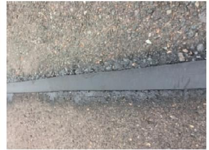
Das **Corabit Rissband KK** ist ein für den Straßenbau entwickeltes kaltklebendes, co-extrudiertes Rissband auf Bitumenbasis mit einer synthetischen Klebeschicht.
