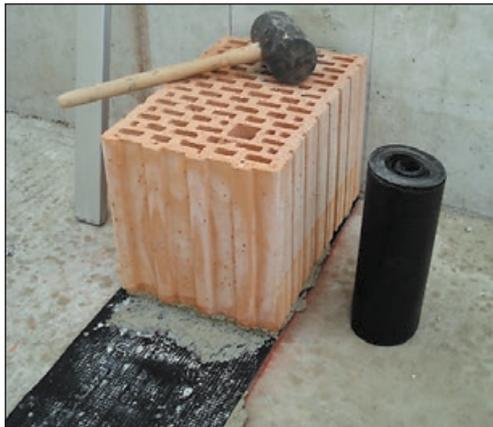
Die Mauersperrbahn schützt das Mauerwerk vor aufsteigender Feuchtigkeit.
