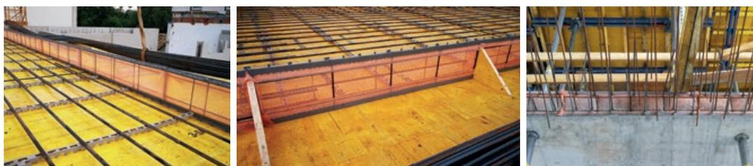
ETAP und ETAP-W ist die beste Lösung um Arbeitsfugen mit Eisendurchdringung abzuschalen. Die Schubtragfähigkeit des ETAP stellt statisch die beste aller Abschaltungsalternativen dar. Das ETAP verbleibt im Beton, erzeugt eine einwandfreie Untersicht und erspart zeitaufwändiges Ausschalen.
