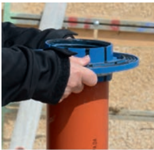
Aufstecken. Dicht.
