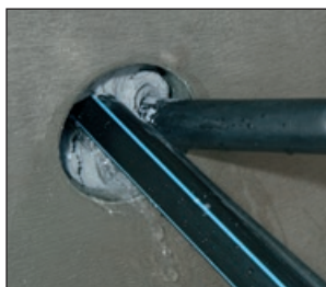
Füllen des Ringspalt
