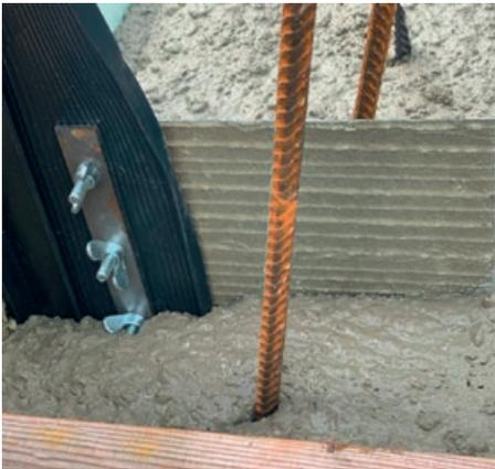
Übergang, Fugenbandanschluß - VIBA-Sinterflex
