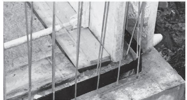
Dichtblech-M im Bereich zweischaliger Wände
