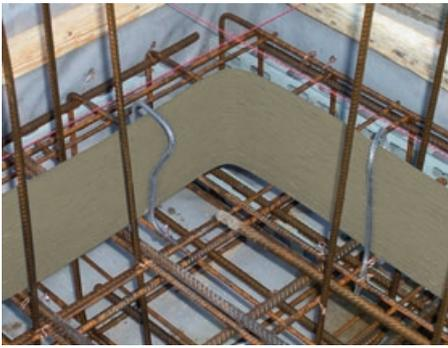
Eckverbindung, mit Omega Bügel an der Bewehrung gesichert
