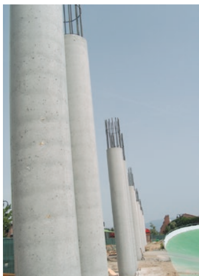
Ausführung STANDARD (Spiral) Betonoberfläche mit leichter Abzeichnung der spiralförmigen Wickelstruktur
