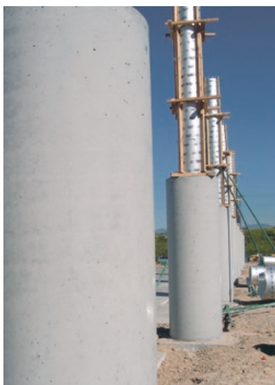
Ausführung TUBE PLUS (glatt) Die Inneneinlage aus Folie bewirkt eine glatte Oberfläche mit Sichtbetonqualität
