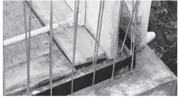
Dichtblech-M Premium im Bereich zweischaliger Wände
