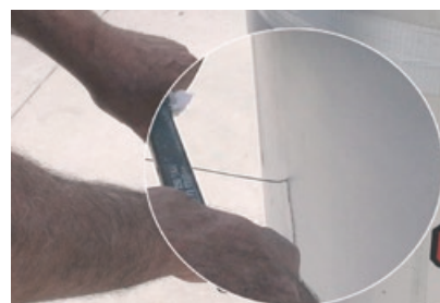
Schnelles Ausschalen mittels Reißleine
