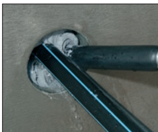
Füllen des Ringspalt
