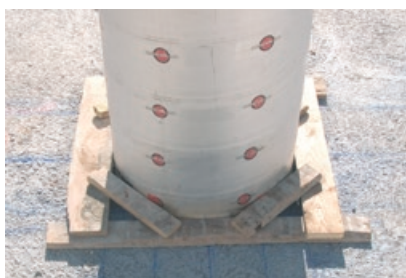
Schalrohr an der Unterseite durch Holz sichern (befestigen)
