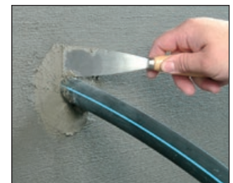
Verspachteln mit Schnellzement
